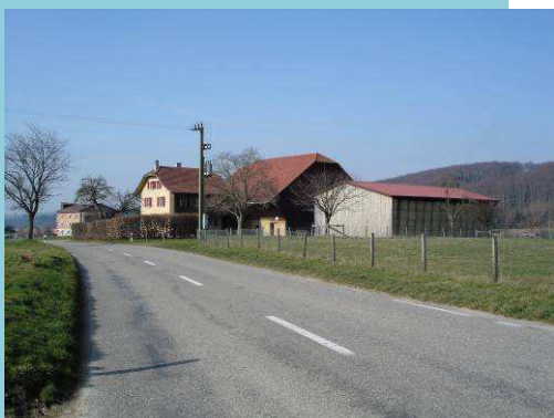
Figure 30: Bâtiment de stockage avec avant-toit pour protéger les balles de foin (Miserez, La Baroche)
