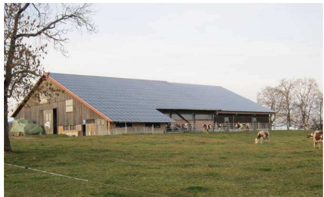
Figure 33: Pan Sud d'une ferme entièrement couvert de panneaux photovoltaïques (Les Cemiers, Saulcy)
