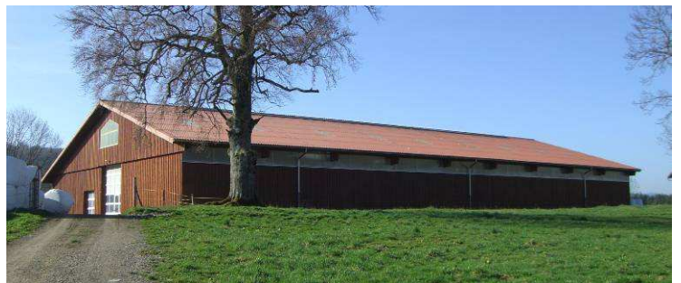
Figure 20: Volume simple, façades boisées, pignon symétrique, éclairage linéaire sous avant-toit, éternit en toiture avec plaques translucides (Le Paigre, Lajoux)
