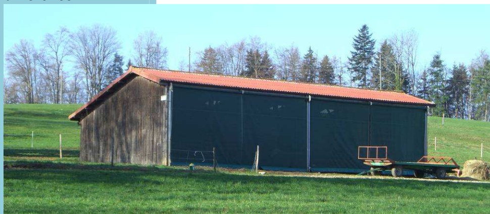
Figure 23: Utilisation de filet coupe-vent comme paroi ventilée (Saulcy)
